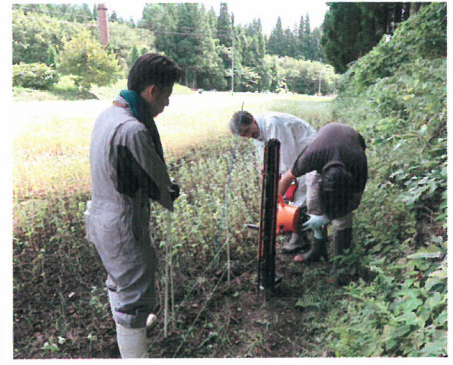
スマートフェンスの設置
