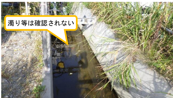
(写真 2 - 3) 排水路の濁り等の状況
