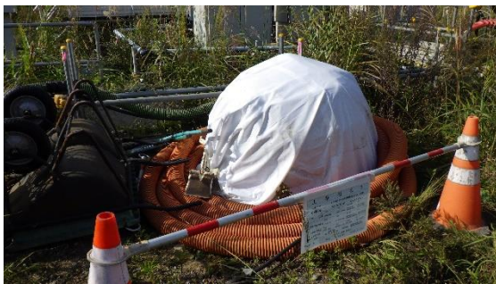
(写真 2 - 2) 排水路清掃資材の仮置状況
