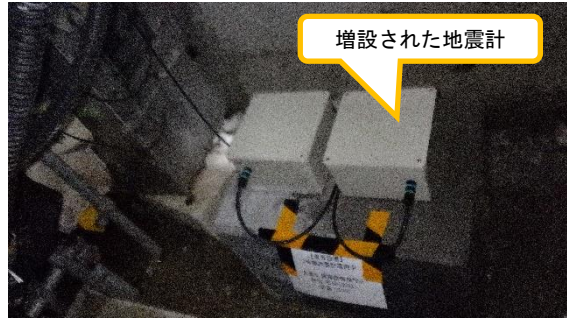
(写真1-2) 今回の状況 (令和3年10月5日撮影)
