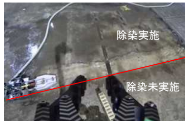
床面の高圧水除染状況
