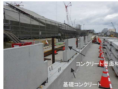
コンクリート壁面材設置状況
