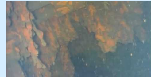
ペDESTAL※ 3 内側の状況
