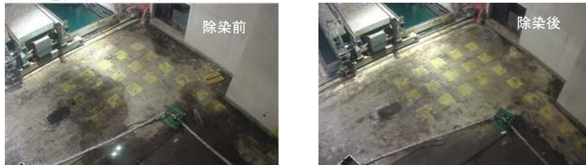
オペフロ南西部の除染状況
