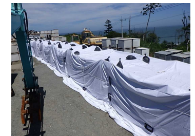
ノッチタンク仮設シート養生
