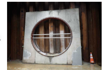
写真②推進坑口構築完了状況 (2021年8月18日撮影)
