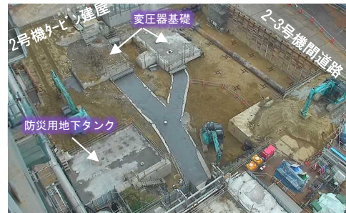
2号機原子炉建屋南側ヤード状況
