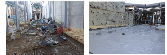
がれき撤去前
