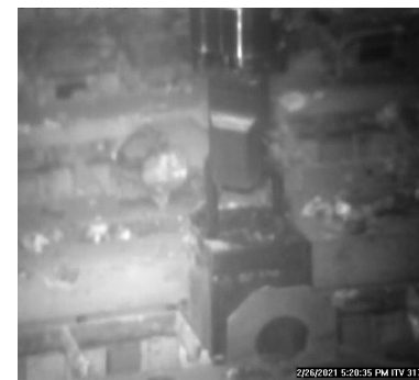
3号機での燃料の吊り上げ (566体目)
