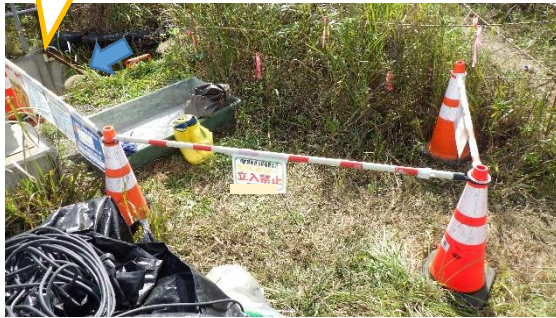
(写真3-1) 排水路進入路の区画の状況 (北側から撮影)
