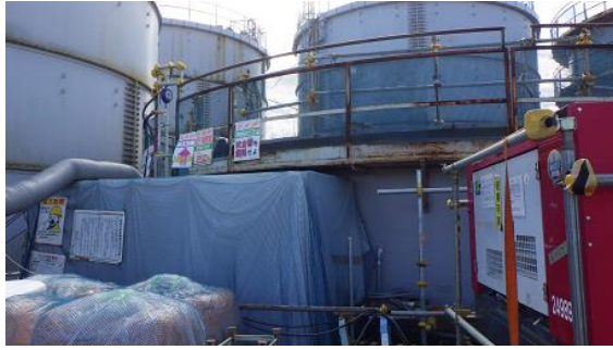
(写真2-3) 解体中のタンクの状況
