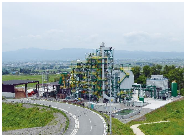
写真：木質バイオマス発電所（提供：(株)グリーン発電会津）
