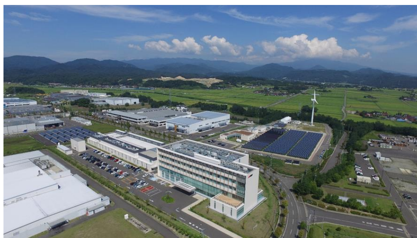
FREA 全景 (提供: 福島再生可能エネルギー研究所)
