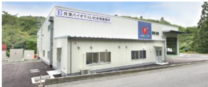
共栄バイオマスいわき南発電所（提供：共栄㈱）
