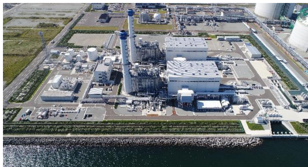
福島天然ガス発電所（提供：福島ガス発電㈱）
