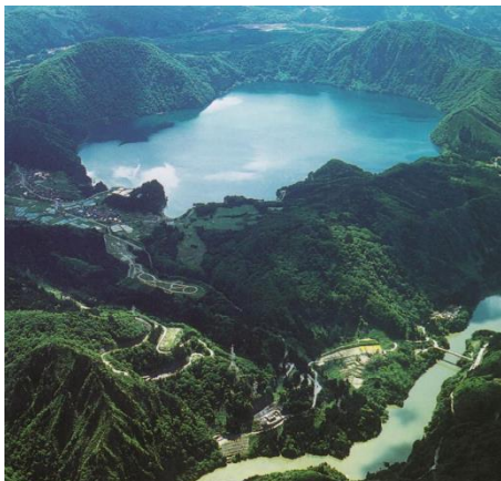
沼尻第二揚水発電所（提供：東北電力㈱）
