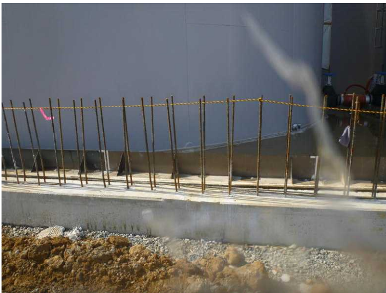
○ J1 タンクエリア 嵩上げの鉄筋の配筋状況
