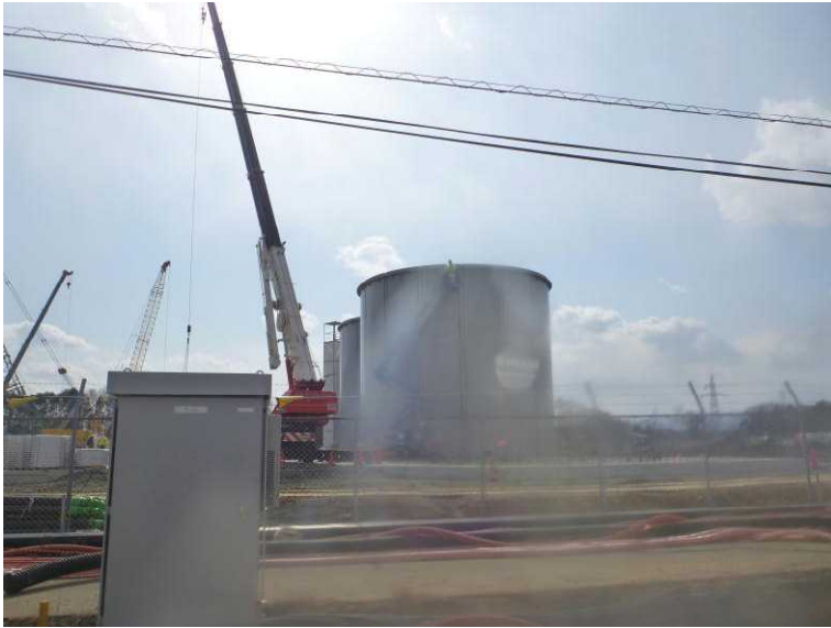
○ J1 タンクエリア 建設状況
