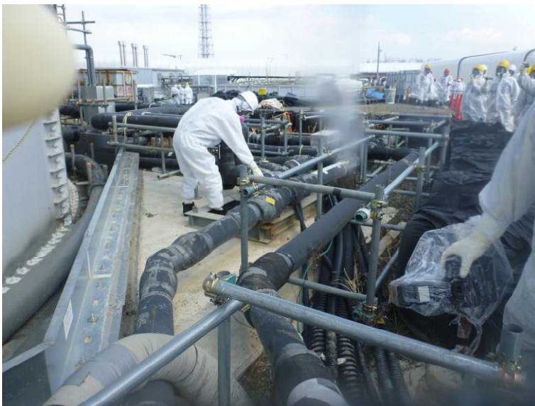
○ H6 タンクエリア タンク受入弁 V346 及び V347 付近
