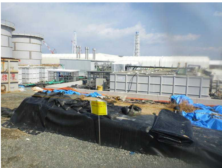
○ H6 タンクエリア 汚染土壌の遮蔽状況
