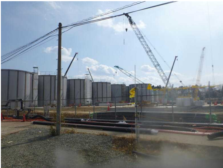
○ J1 タンクエリア 建設状況
