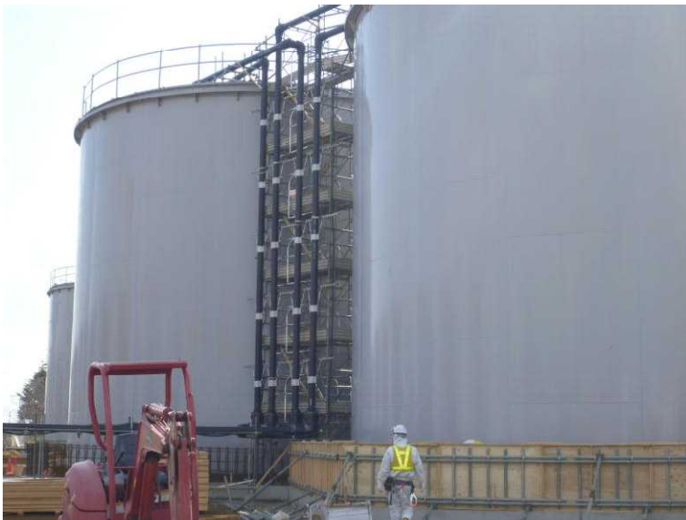
○ J1 タンクエリア 建設状況
