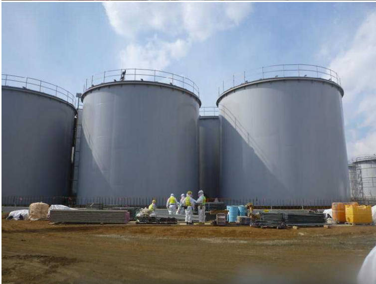
○ J1 タンクエリア 建設状況
