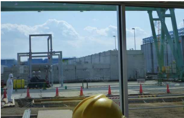
○使用済セシウム吸着塔 一時保管施設 (第二施設)
