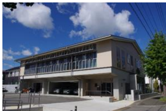
福島県須賀川土木事務所 (庁舎としては東北で初めて Nearly ZEB 認証を取得)
