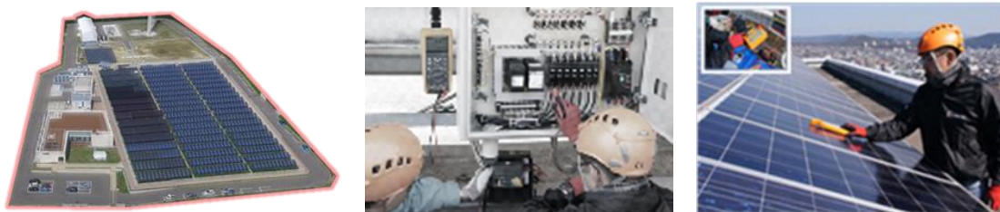
1367 図：福島再生可能エネルギー研究所（FREA）実証フィールド（提供：福島再生可能エネルギー研究所） 1368
