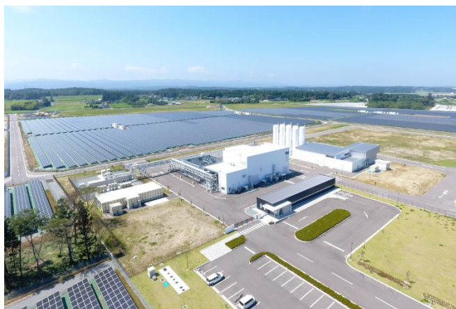
福島水素エネルギー研究フィールド（提供：NEDO）
