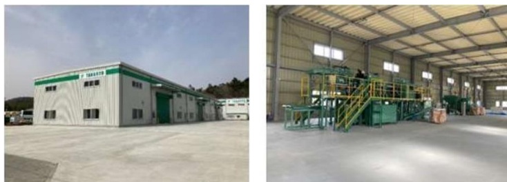
1378 図：太陽光パネルリサイクル施設（提供：㈱高良） 1379
