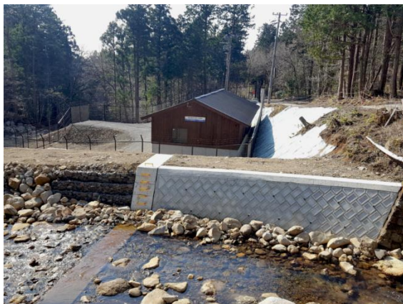
図：信夫山・遠藤ヶ滝・大玉第一小水力発電所(100kW) (提供：信夫山福島電力(株))
