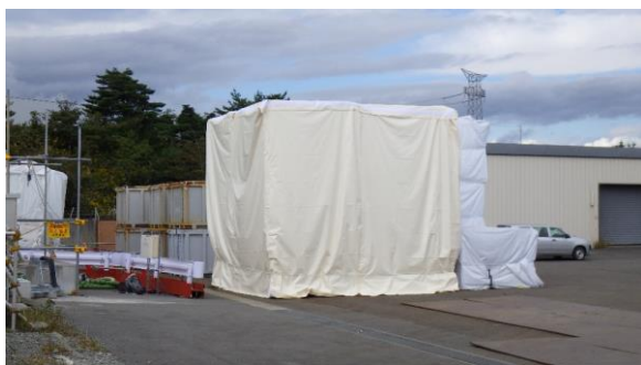
(写真 3) 本設シート養生の状況
