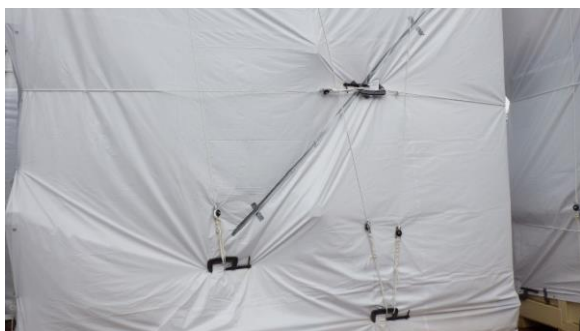
(写真 2 - 3) 仮設シートは風対策としてロープとクランプにより固縛が実施されていた
