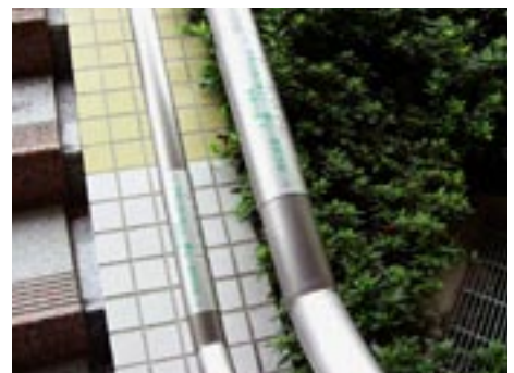
点字サインの例(郡山堂前地下歩道)
