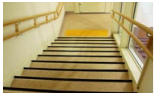
段鼻に滑り止めを設け色別した階段 (県立大野病院)
