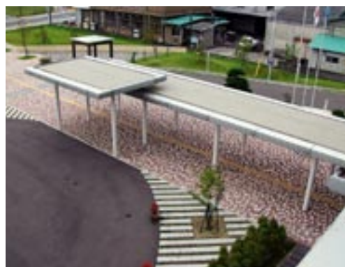
雨天時でも支障なく乗降できる車寄せ (新地町役場)
