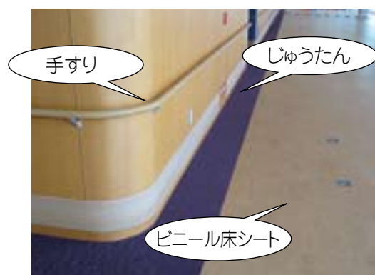
床材の違いと手すりによる誘導 (国際障害者交流センター「ビッグ・アイ」)
