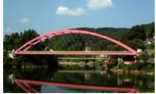
下路形式の橋梁
