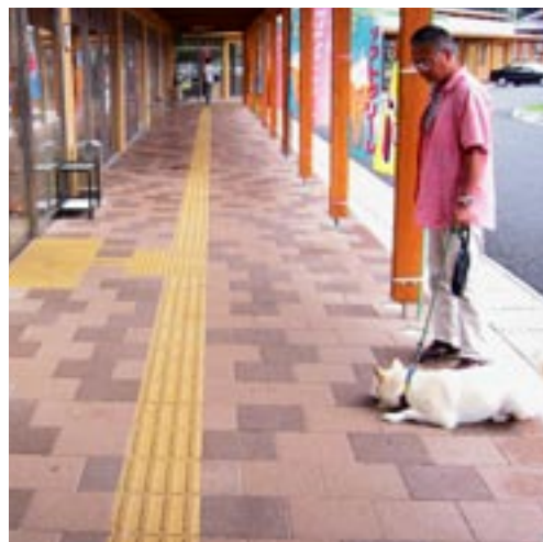
ブロックタイプの舗装材を敷設した通路 (道の駅はなわ)
