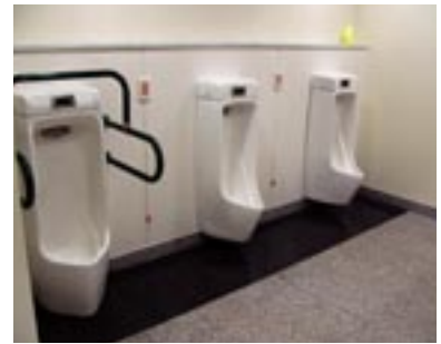
手すり付きストール式(左)と低リップ式の小便器
