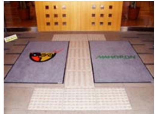
誘導用ブロックを避けて水拭きマットを敷いている例 ( 誘導用ブロック色は高輝度黄色が望ましい。 )
