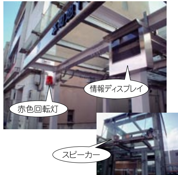
地下横断歩道内の状況を出入口のディスプレイに映し出す防犯対策と赤色回転灯、スピーカー（福島市本町地下歩道）
