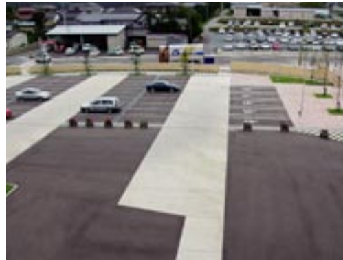
段差のない駐車スペース(新地町役場)
