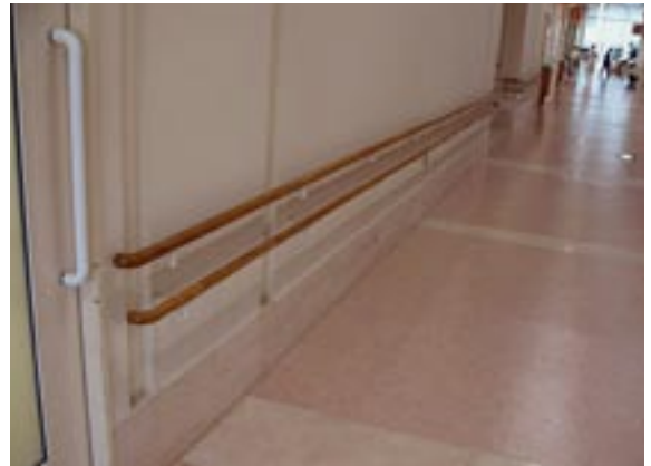
連続して設けられた手すりの例 (県立大野病院)
