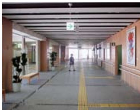
建物内の視覚障がい者誘導用ブロック (くまもと県民交流会館「バレア」)
