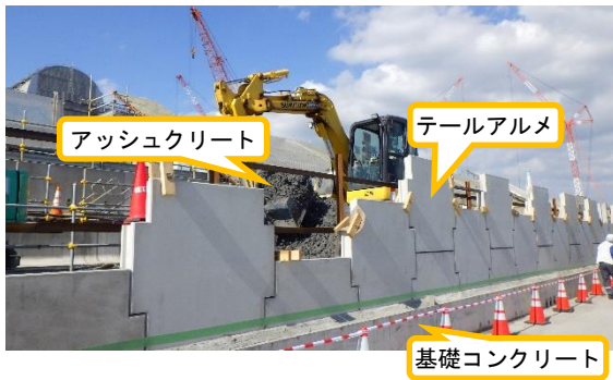
(写真1-1) コンクリート壁面の建設状況 (南東側から撮影)
