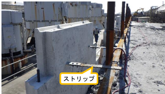
(写真1-2) テールアルメの建屋側の状況 (北西側から撮影)
