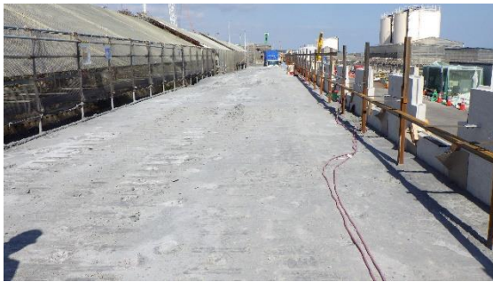
(写真2) 固化したアッシュクリート (南側から撮影)
