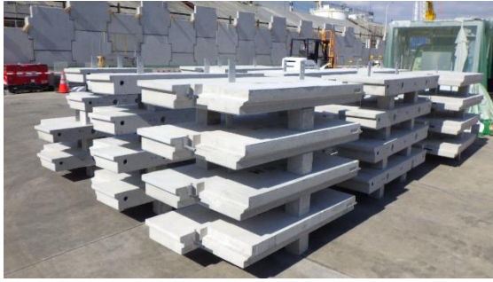
(写真1-3) 設置前のテールアルメの状況 (南東側から撮影)
