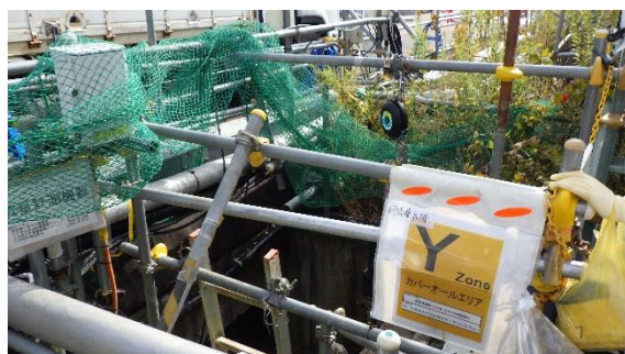
(写真 4) K排水路入口の状況 (4号機西側)
