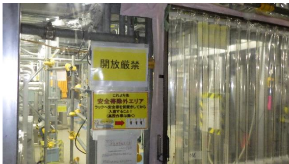
(写真2-1) 3号機タービン建屋のハウス入口付近の状況
