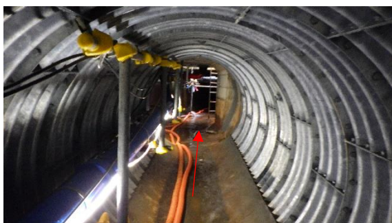
(写真5) ドライアップ作業は完了 (矢印は勾配)
