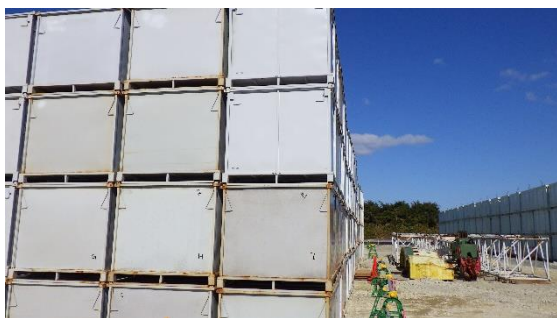
(写真 3) 一部のコンテナには錆が見られた
