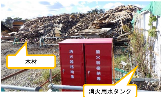
(写真 1 - 2) 木材の仮設集積場所付近の消火器設置状況
