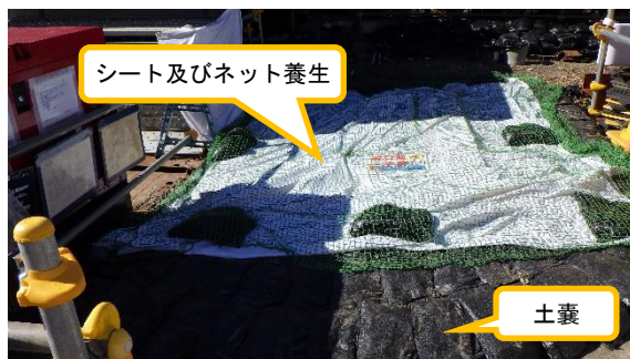
(写真3) 掘削箇所の状況
