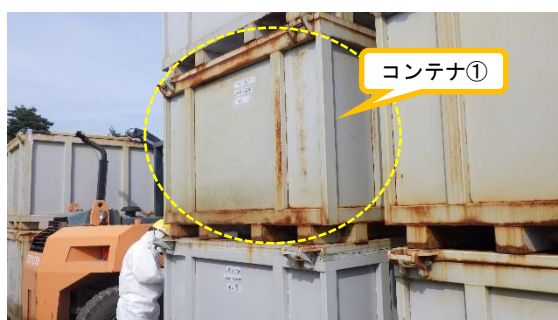
(写真1-1) 内包水が滴下したコンテナ①の状況 (南側から撮影)
