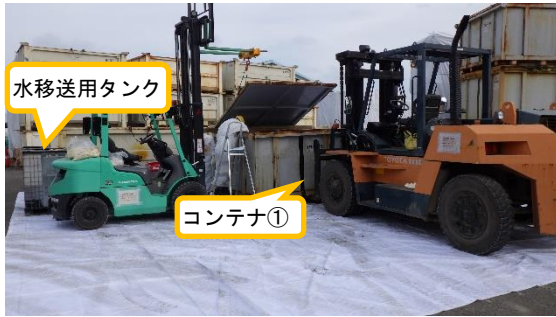
(写真 2 - 3) コンテナ①の水抜き状況 (西側から撮影)
