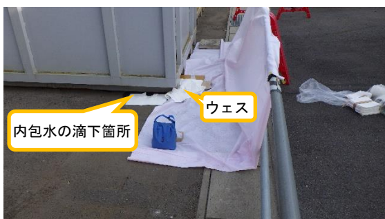
(写真2-2) 側溝への流入防止の措置の状況 (西側から撮影)
