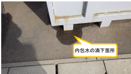
(写真1-4) 舗装面(地面)に滴下した水の状況 (南西側から撮影)
