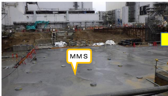
(写真2-1) MMS打設による埋め戻しの状況 (西側から撮影(10月13日))
