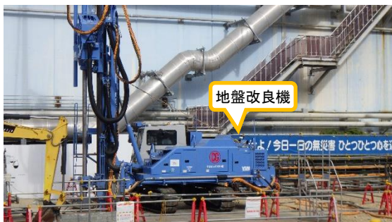
(写真3) 地盤改良の状況
