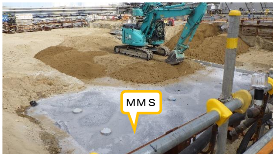
(写真2-3) 土砂による埋め戻しの状況② (南西側から撮影)
