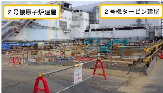
(写真1) 2号機原子炉建屋南側ヤード概観 (南西側から撮影)
