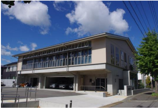
改築工事で ZEB 化を実現した須賀川土木事務所
