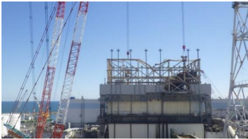
福島第一原子力発電所 1号機 (令和元(2019)年9月撮影)
