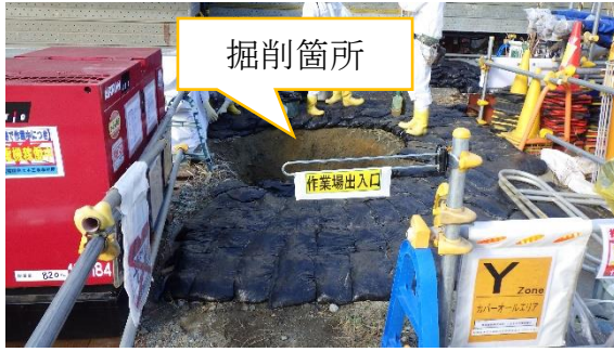
(写真1-1) 掘削作業中の現場の状況
