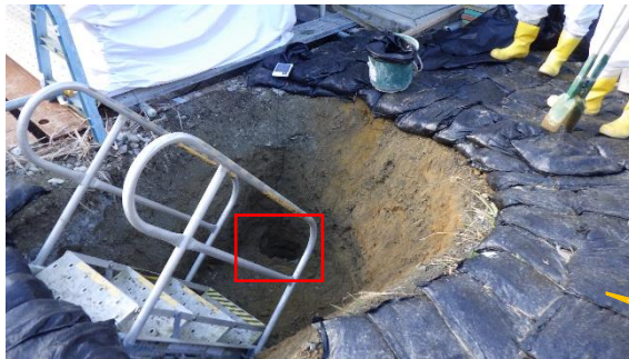
(写真1-2) 陸側遮水壁内側の掘削状況について
