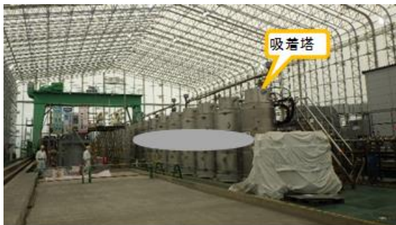
(写真2-1) 高性能ALPSの建屋内の状況 (入口付近から撮影)
