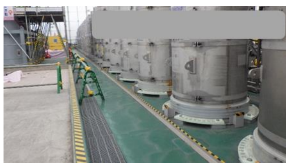
(写真 4) 床面及び吸着塔の状況 (結露は確認されない。)
