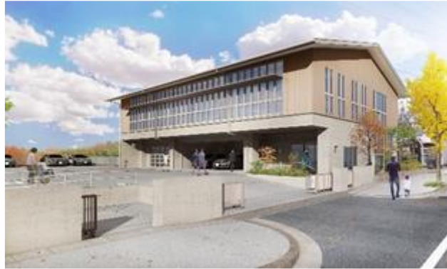
4 5 改築工事で ZEB 化を実現した須賀川土木事務所 6
