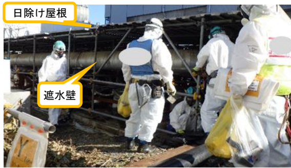
(写真 2 - 2) 支柱の移動作業の状況①
