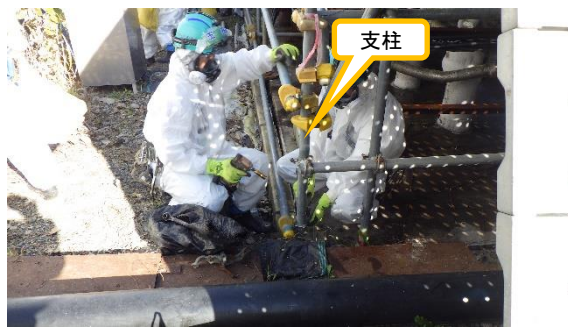
(写真 2 - 3) 支柱の移動作業の状況②
