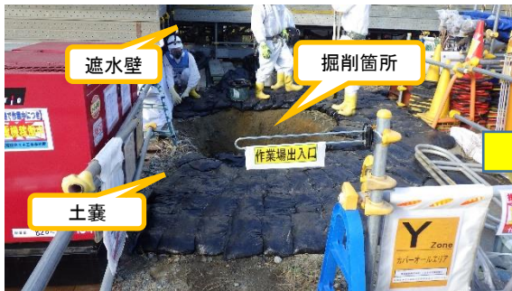
(写真1-1) 遮水壁内側（東側）の掘削箇所の状況（令和3年11月12日撮影）
