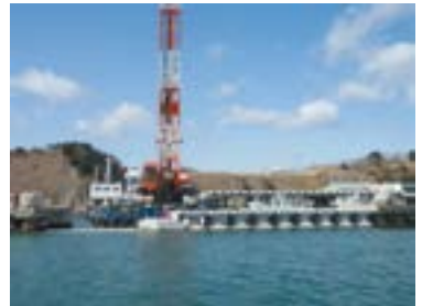
▲いわき市久之浜港の工事状況
