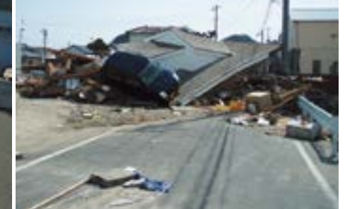
県道豊間四倉線の被災状況
