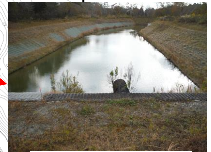
北西方向より撮影
