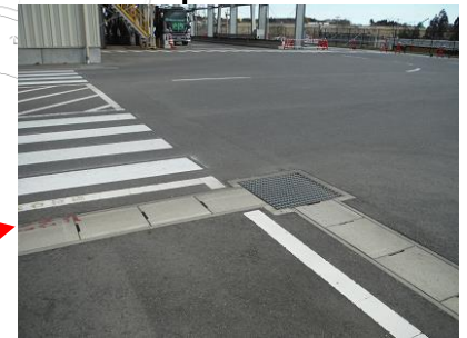
南西方向より撮影
