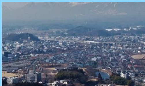
白河市街地を通る高速交通体系 東北新幹線・東北自動車道 (白河市)
