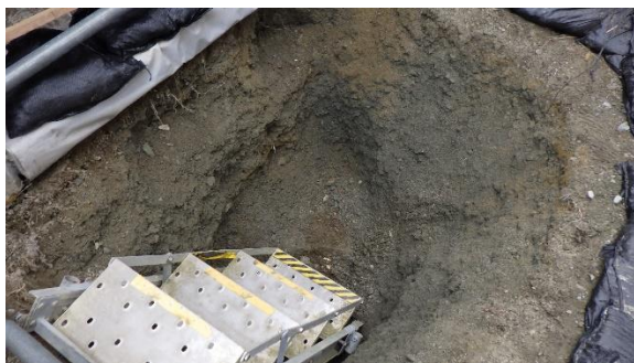
(写真 2 - 2) 掘削箇所②（北側）の状況
