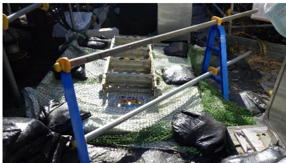
(写真 2 - 2) 掘削箇所②（北側）の状況
