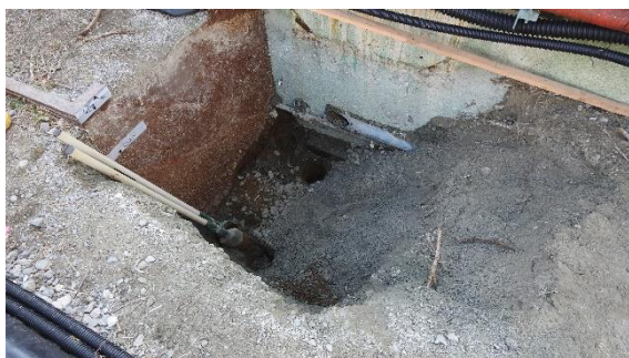
(写真 2 - 3) 掘削箇所③（南側）の状況
