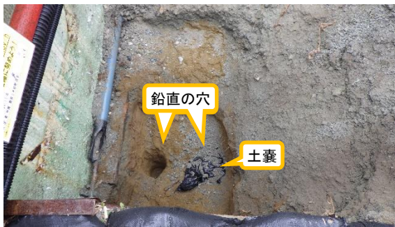
(写真 2 - 2) 掘削箇所③の状況② (東側から撮影)
