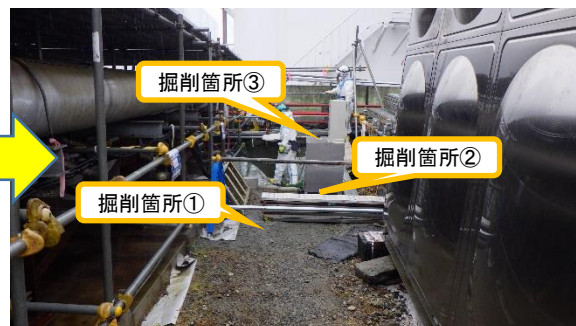
(写真1-2) 同左(令和3年11月22日撮影) 掘削箇所
