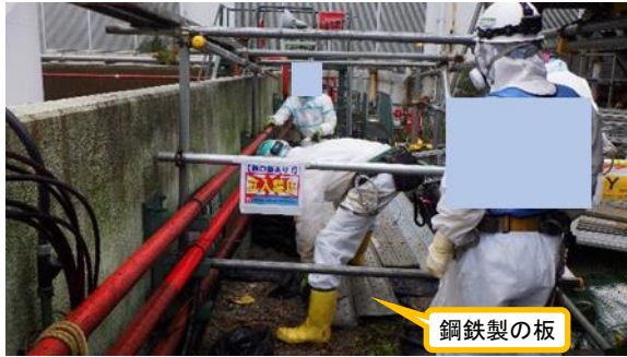
(写真 2 - 1) 掘削箇所③の状況① (東側から撮影)
