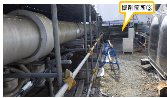
(写真 2 - 2) 11 月 24 日の掘削現場の状況 (掘削箇所①及び②は埋め戻されていた)
