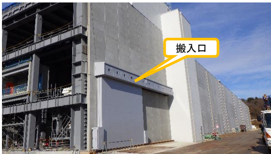
(写真 4 - 2) 建屋東側の状況
