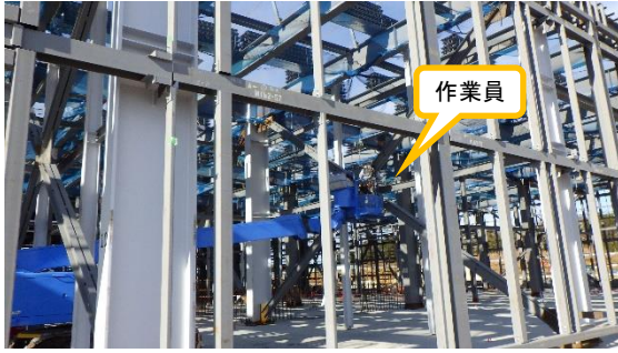
(写真 2 - 2) ボルトの本締作業の状況
