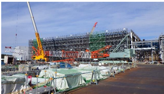
(写真2-1) 建屋の鉄骨組立の状況
