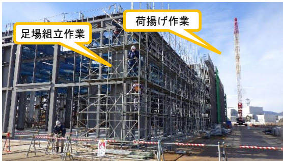
(写真 3 - 1) 建屋北側の状況 (北東側から撮影)
