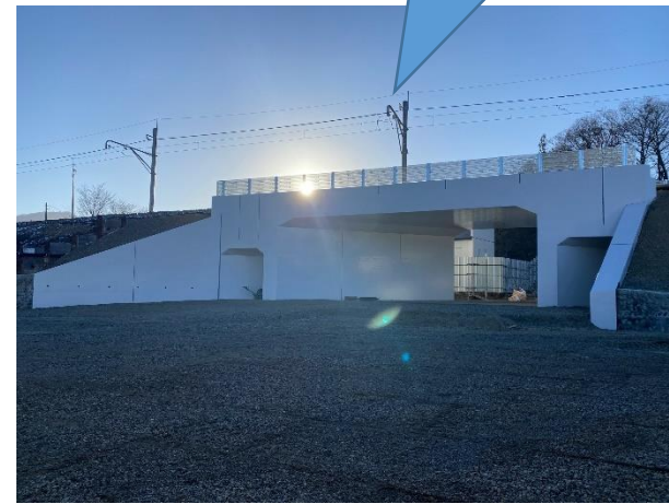
南会津町田島地内
