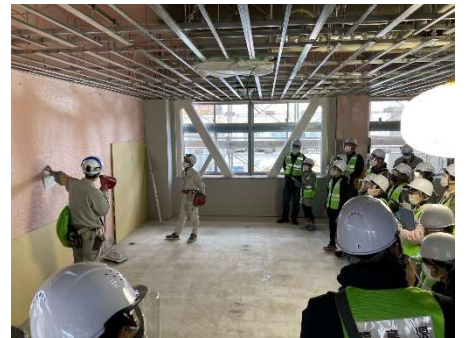
施工状況見学
