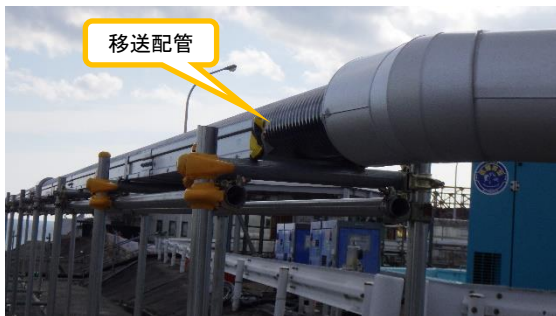
(写真3-1) 移送配管の敷設状況
