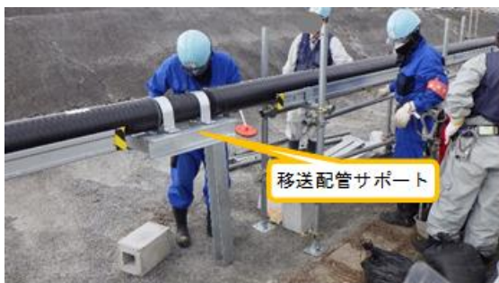
(写真3-2) 移送配管サポートの設置作業の状況
