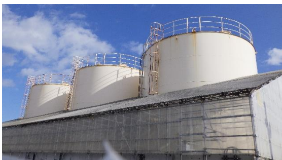
(写真1-1) 集水タンクの設置状況 (南西側から撮影)
