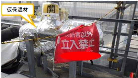
(写真2) 集水タンクへの接続部付近の移送配管の状況
