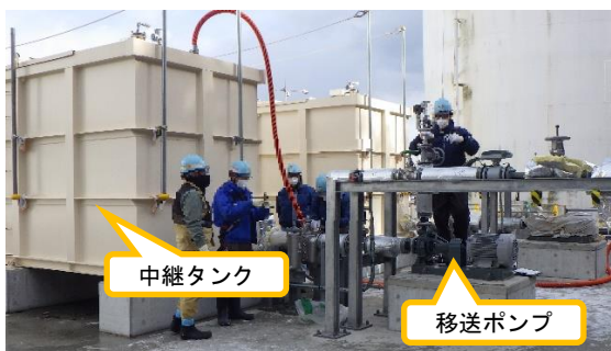
(写真2-1) 中継タンク及び移送配管の設置状況 (5号機タービン建屋南側) (前回(令和3年10月8日)撮影)
