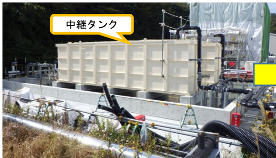
(写真2-1) 中継タンク及び移送配管の設置状況 (5号機タービン建屋南側) (前回(令和3年10月8日)撮影)
