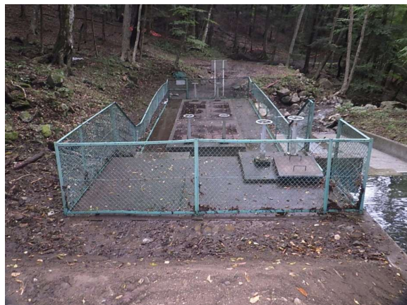
【復旧状況 土砂撤去完了】
