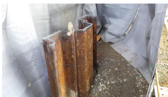
(写真1-2) 鋼矢板の設置状況 (3枚の鋼矢板が設置)
