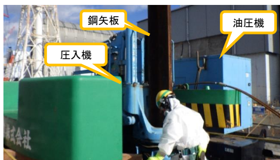
(写真1-3) 鋼矢板の設置に使用する機器の状況
