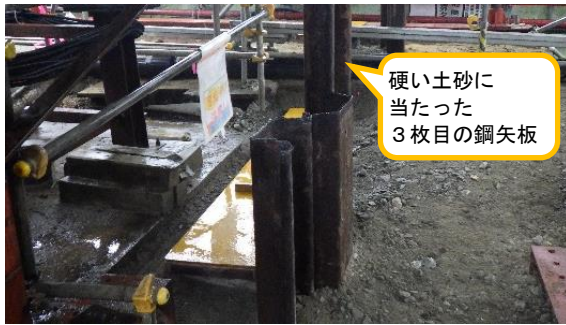
(写真 1 - 2) 北側の鋼矢板の設置状況 (鋼矢板 3 枚が設置されている。)
