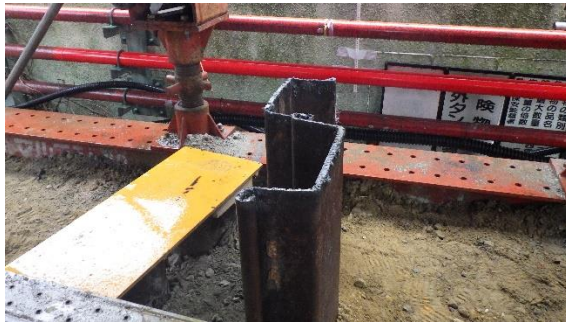
(写真 1 - 3) 南側の鋼矢板の設置状況 (鋼矢板 2 枚が設置されている。)
