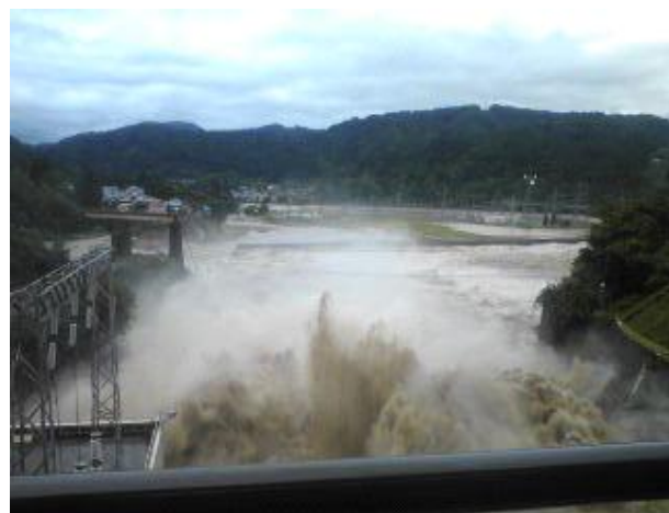
【写真1. 2】JR只見線 第6只見川橋梁流出
