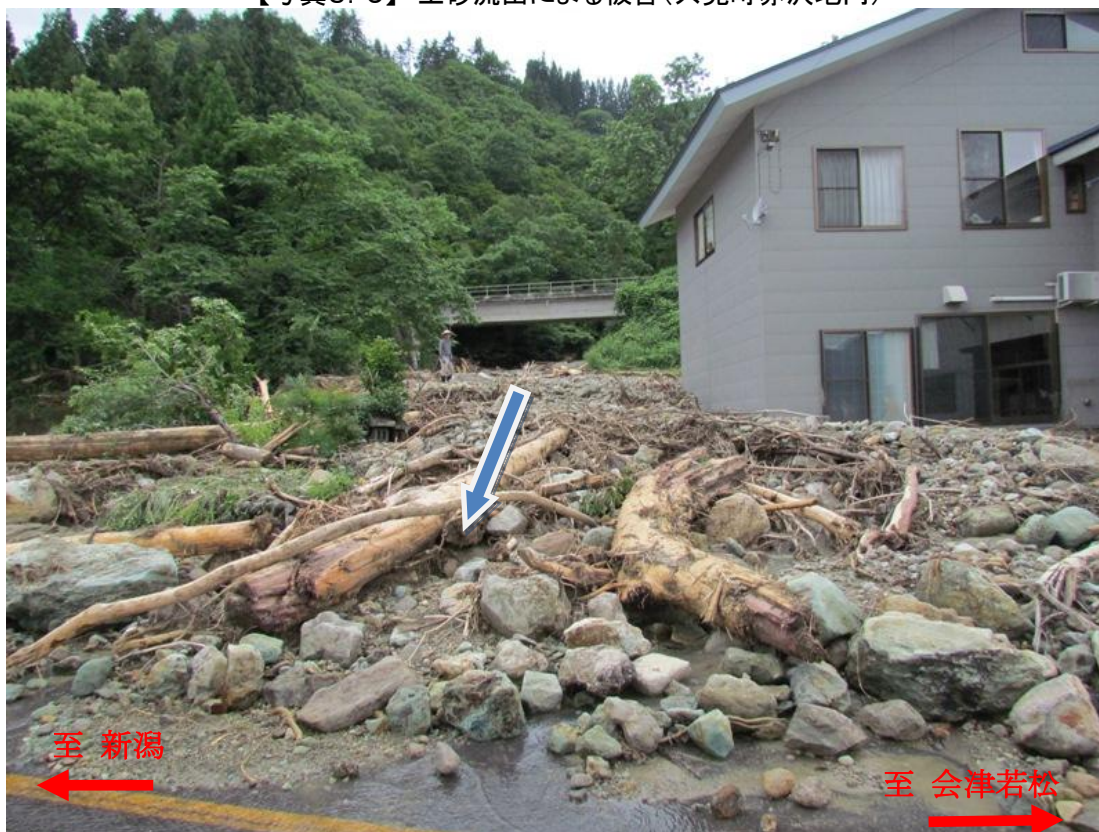
【写真3. 5】土砂流出による被害(只見町赤沢地内)
