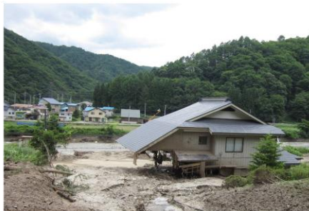
【写真5.7】被災状況（カシノ木沢：南会津町地内）
