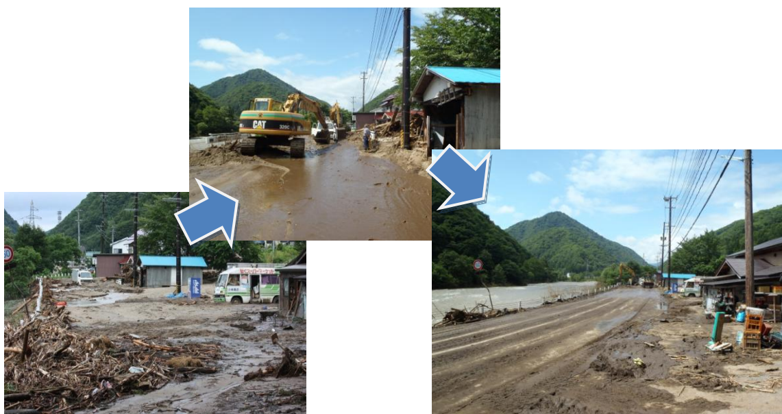
【写真4. 8】国道401号(内川地区)土砂流出・復旧状況
