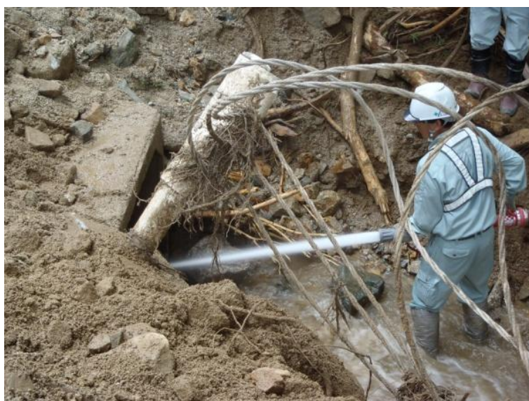
【写真4.13】沢部埋塞土砂撤去状況
