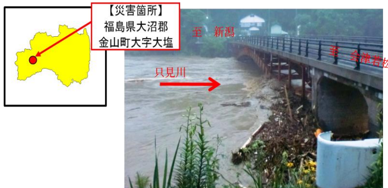
【図5. 8】 国道252号二本木橋被災概要
