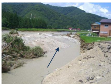
【写真5.4】被災状況
