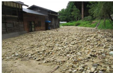
【写真5.12】被災状況（沼頭沢：只見町地内）
