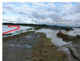
阿武隈川(玉川村) 【台風15号による洪水氾濫】
