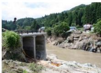
国道252号二本木橋（金山町）
