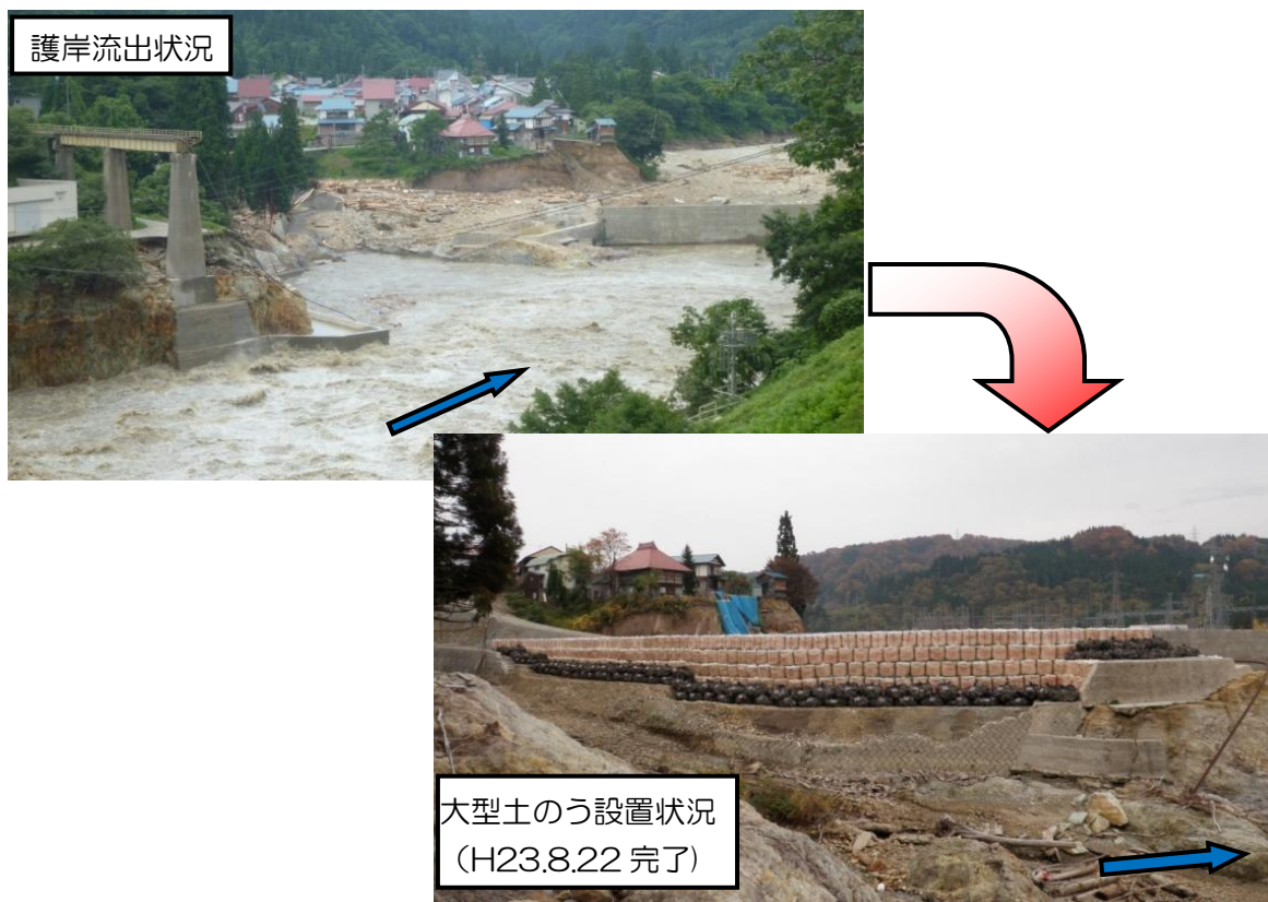
【写真4.11】 応急復旧状況(只見川:金山町本名)
