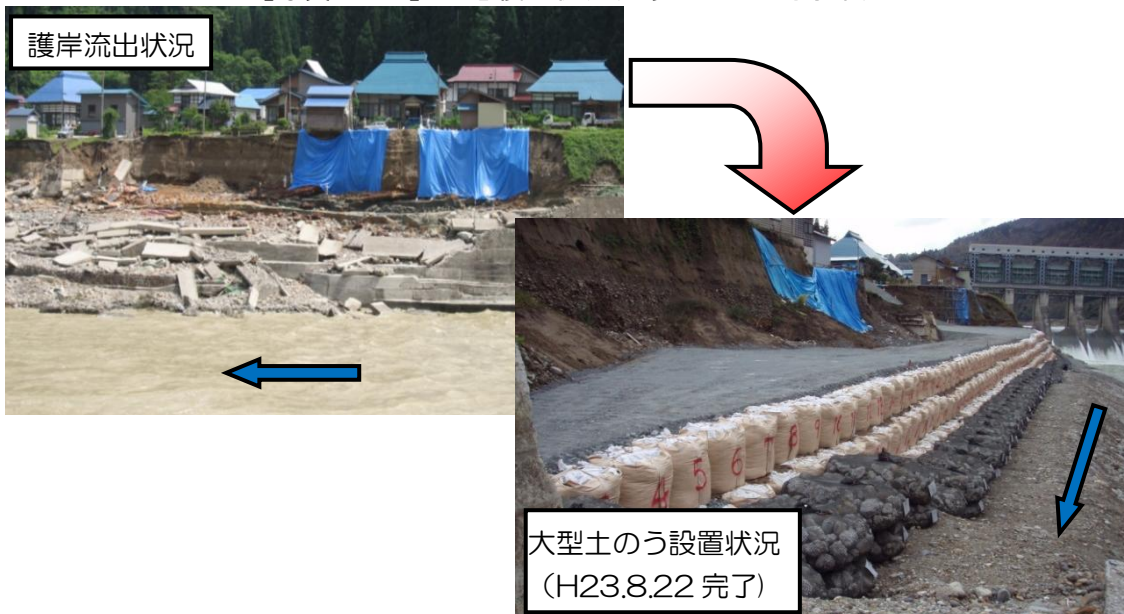
【写真4.10】 応急復旧状況(只見川:金山町水沼)
