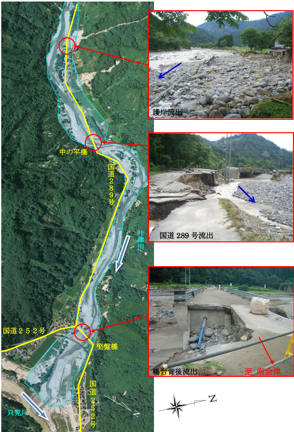
(4) 叶津川(只見町叶津地内)
