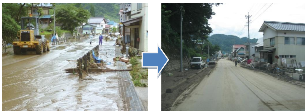
【写真4. 4】国道252号浸水後及び応急復旧状況(金山町西谷地区)
