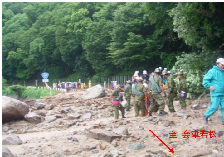
【写真3. 7】国道401号脱出・救出状況（南会津町内川地内）
