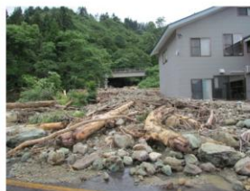
御東沢(只見町) 【新潟・福島豪雨による土砂災害】
