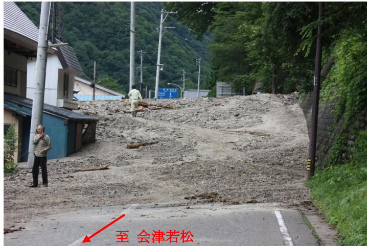
【写真3. 6】 国道401号土砂流出状況（南会津町内川地内）
