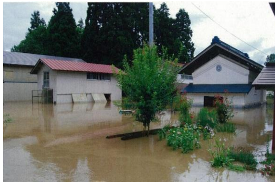
② 西会津町橋屋地区浸水被害状況
