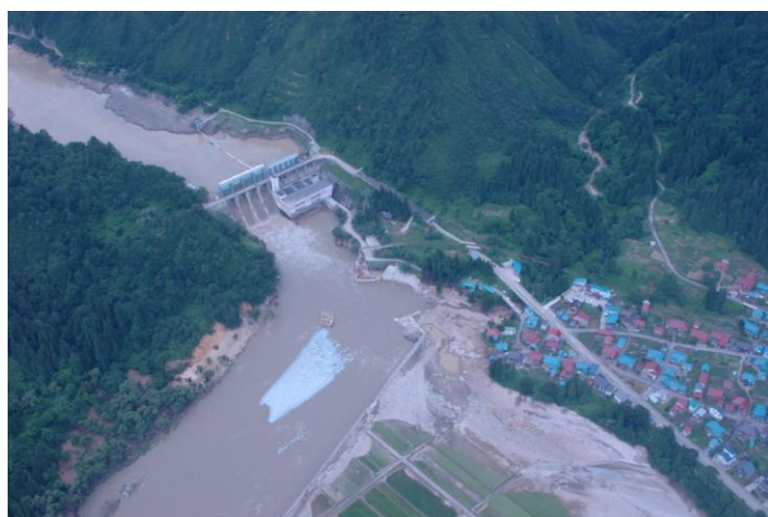
ヘリコプターによる被災状況調査
