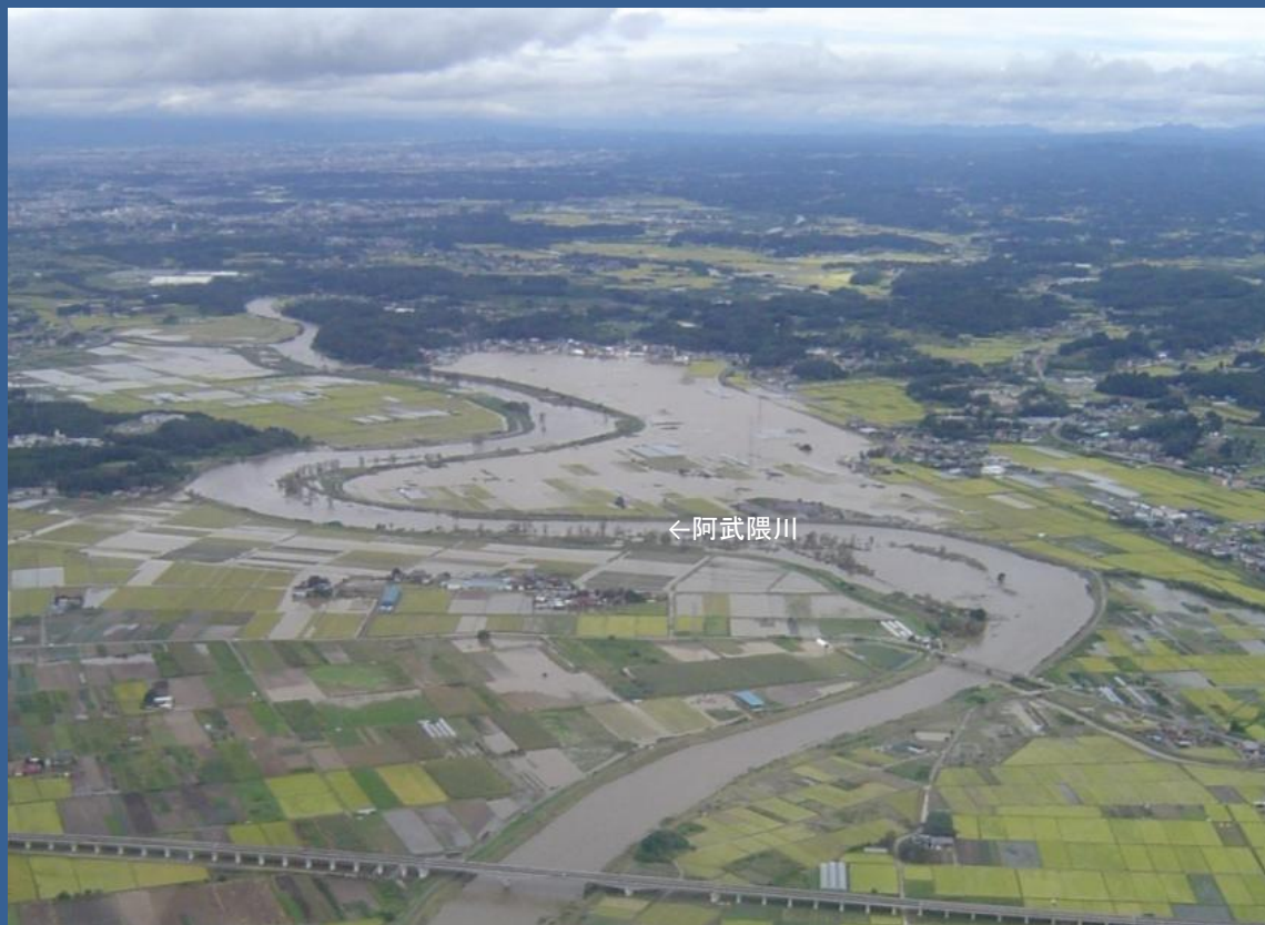
阿武隈川破堤箇所（玉川村中地内）
