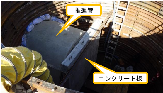
(写真2-2) 下流側到達立坑内の状況② (南側から撮影)
