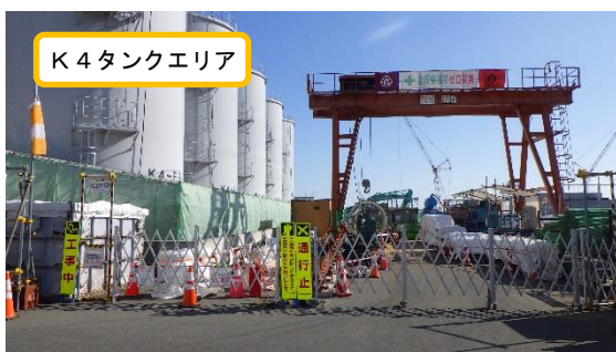
(写真1-1) 両発進立坑入口付近の状況 (西側から撮影)
