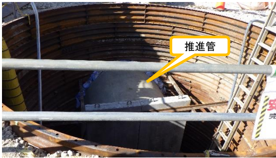
(写真2-1) 下流側到達立坑内の状況① (南東側から撮影)
