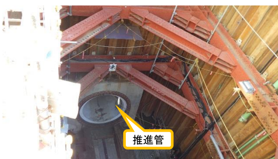
(写真1-2) 両発進立坑内東側の状況 (西側から撮影)
