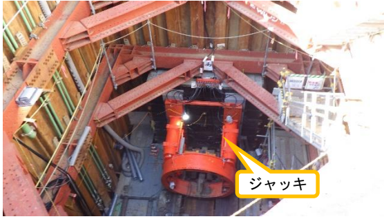
(写真1-3) 両発進立坑内西側の状況 (東側から撮影)
