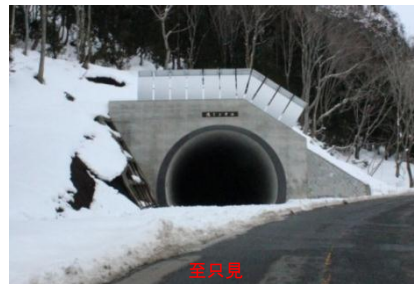
トンネル本体完成
