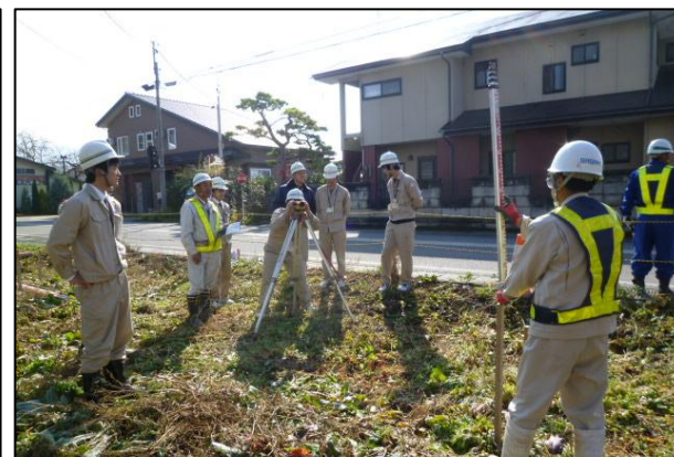
現場実習1:起工測量・丁張設置
