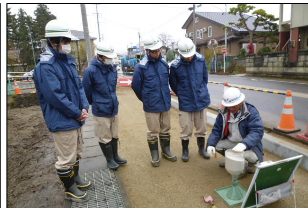
現場実習3:現場密度試験
