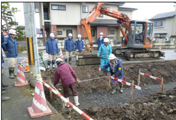
現場実習2:側溝の布設
