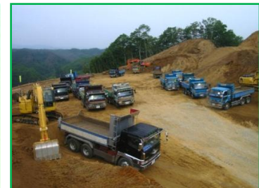
場内ルート見直し前の状況
