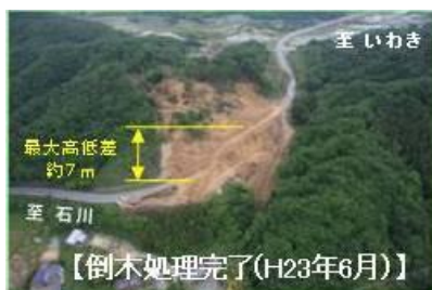
最大高低差約7mの作業路
