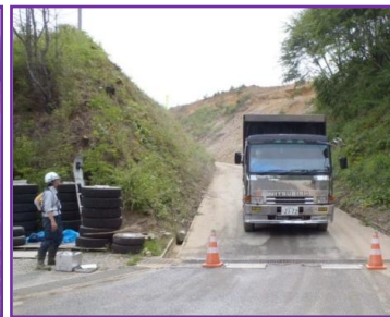
③トラックスケールの設置
