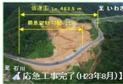
最急縦断勾配11%の仮道工
