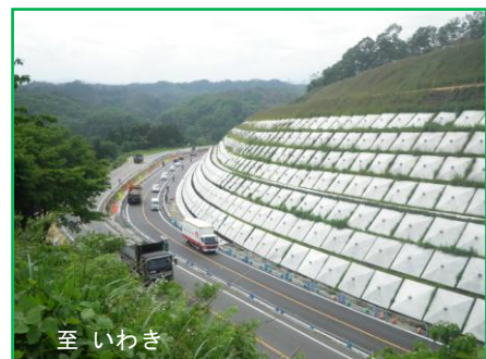
舗装工施工状況（H25年6月中旬時点）
