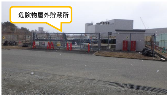
(写真1) 危険物屋外貯蔵所の概観
