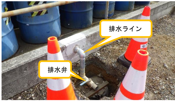
(写真 2 - 3) 排水ライン及び排水弁の設置状況
