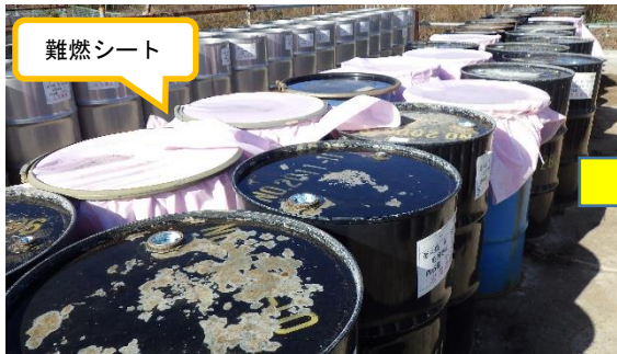
(写真 3 - 1) 前回の難燃シートによる仮養生の 状況 (令和 4 年 1 月 19 日)
