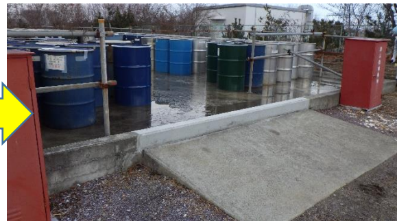
(写真2-2) 堰の嵩上げ状況 (令和4年2月22日撮影)
