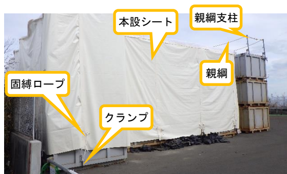
(写真1-2) 同左 (令和4年2月8日南側から撮影)
