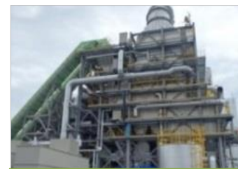
仮設焼却施設
