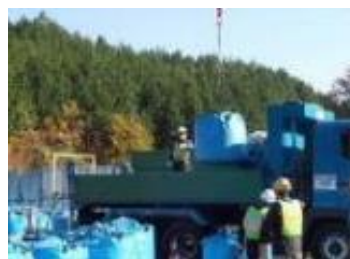
除去土壌等の車両積込状況
