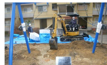
バックホウによる表土除去
