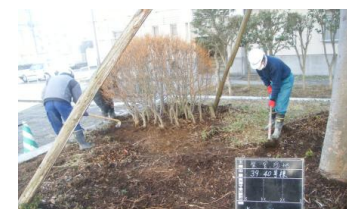
人力による表土除去
