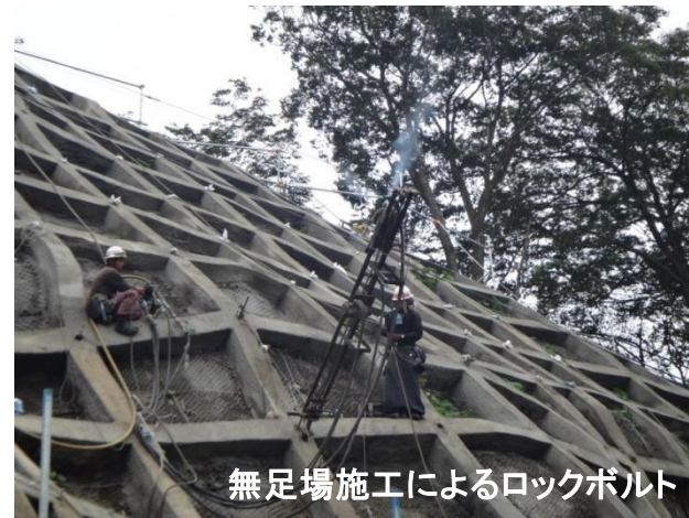
切土工施工状況
