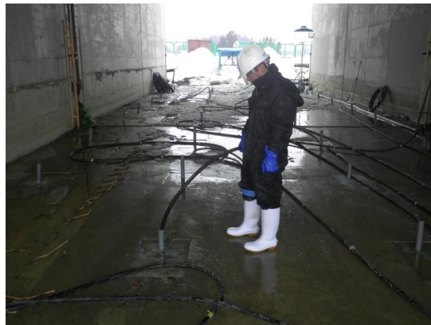
薬液注入工施工状況
