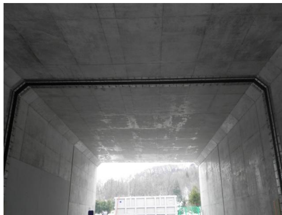
ジョイント目地工完了状況
