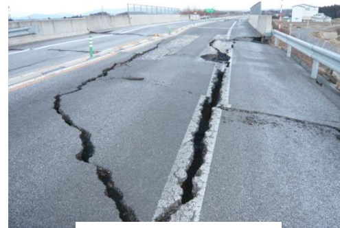
路面の亀裂
