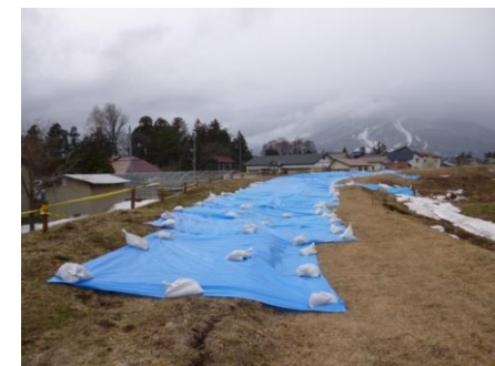
シート張りにより応急復旧
