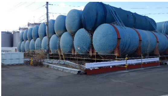
(写真1-2) ブルータンクエリアDの概観② (北東側から撮影)
