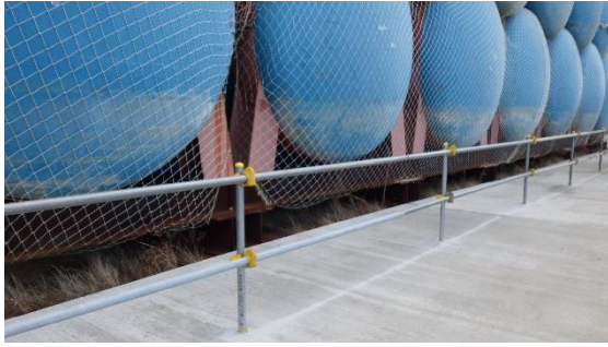
(写真3) 単管パイプによる区画の例 (エリア西側を北側から撮影)
